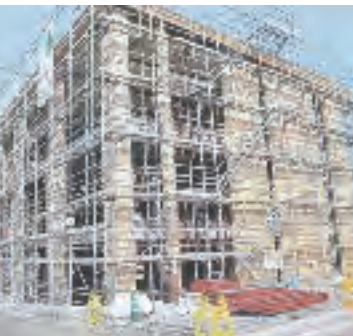
ウッドALCを活用して建設中の共同住宅＝3月
