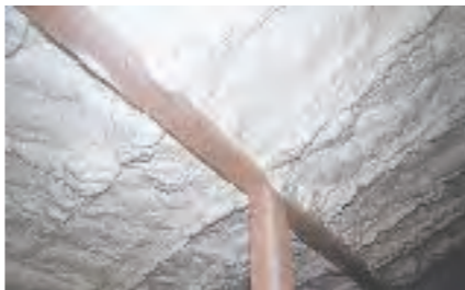
自社施工の断熱材アイシネン
