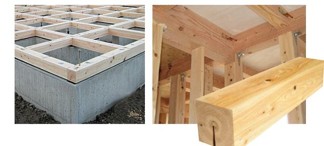
土台や柱は、地元八溝山の天然無垢ヒノキの**芯持ち乾燥材4寸(120mm)角**を使用。防カビ・殺菌・防虫・耐久性に優れています。さらに、時間をかけじっくり乾燥させた含水率の極めて少ない乾燥材を使用しております。
